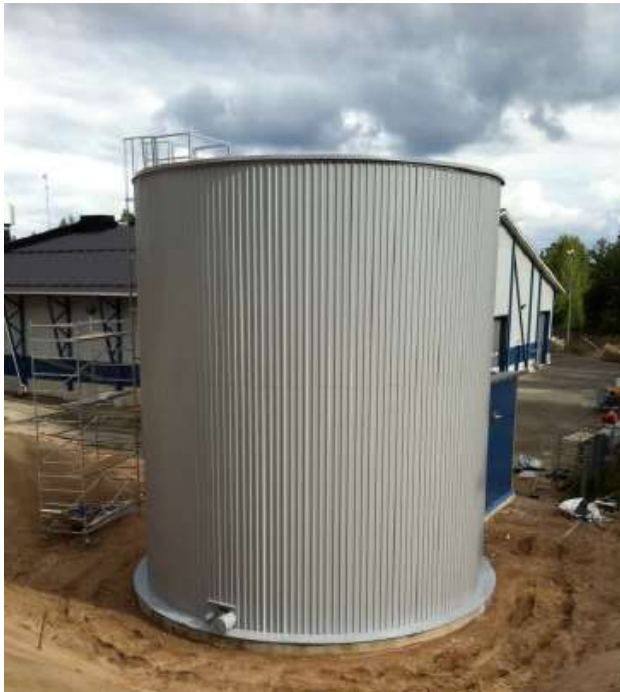
Isolerad sprinklertank
